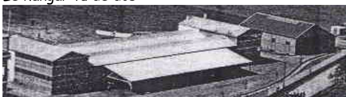
Le hangar vu de dos
